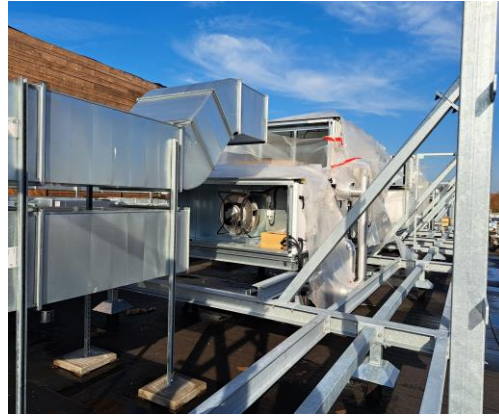
Kanaalwerk t.p.v. luchtbehandelingkasten
