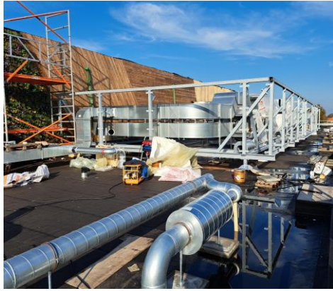
Kanaalwerk t.p.v. luchtbehandelingkasten
